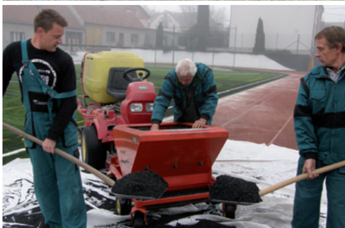
Dokončovací práce na stadionu, zásyp povrchu granulátem
