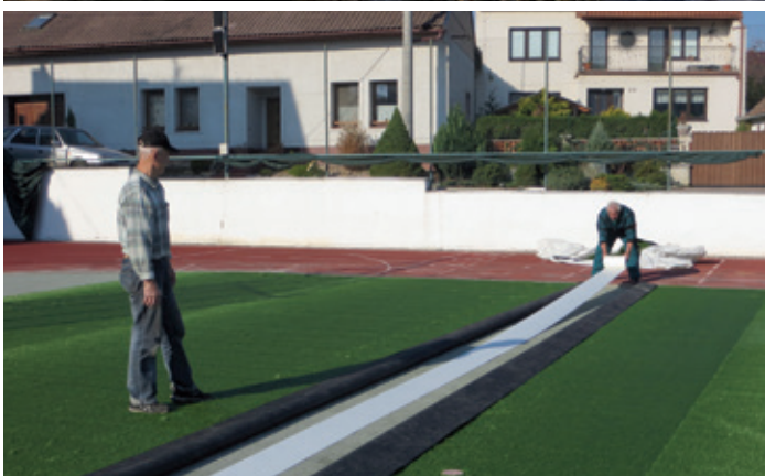
Rekonstrukce školního atletického stadionu – pokládka nového povrchu tzv. třetí generace
