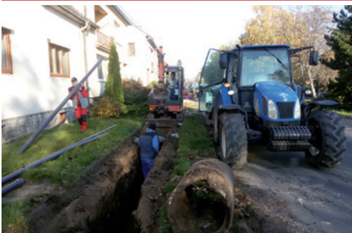
Ulice Nádražní – oprava vodovodního řadu
